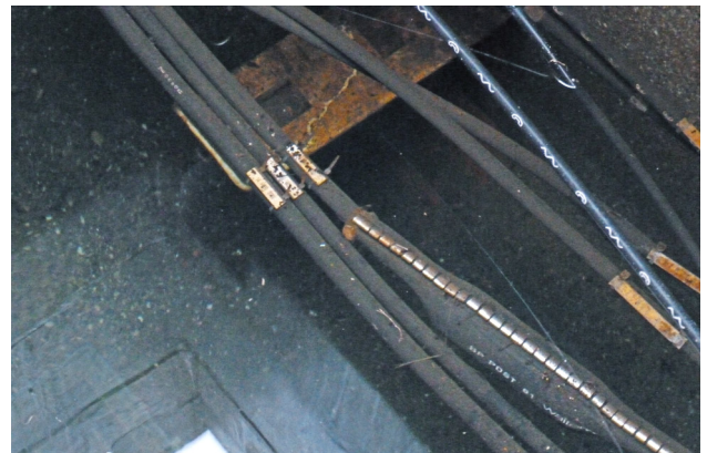
Extreem geval: Deze kabelschacht staat compleet onder water.
